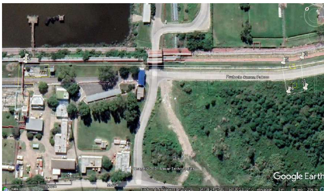
Imagen 2. Sitio de afectación de la obra en zona trampas de scraper Poliducto y lateral a calle interna 6 de la zona Operaciones.
