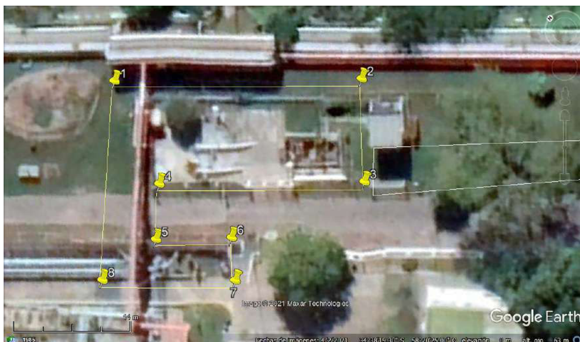
Imagen 1. Sitio de afectación de la obra en zona trampas de scraper Poliducto (polígono amarillo) y lateral a calle interna 6 de la zona Operaciones.
